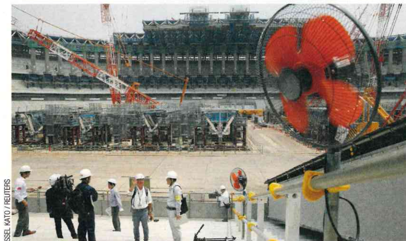
Le chantier du stade olympique de Tokyo 2020 équipé de ventilateurs. Marathon, golf... les épreuves qui se déroulent hors du stade suscitent le plus d'inquiétude.
